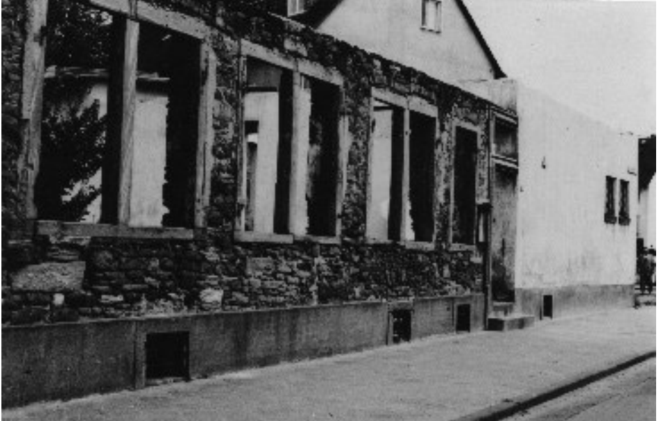
So sah das erste eigene Gemeindehaus aus. Den Saal rechts betrat man von hinten. Dort, wo sich unser heutiges Wohnhaus befindet, war bis zum Umbau 1965/66 eine Ruine vom Krieg.
