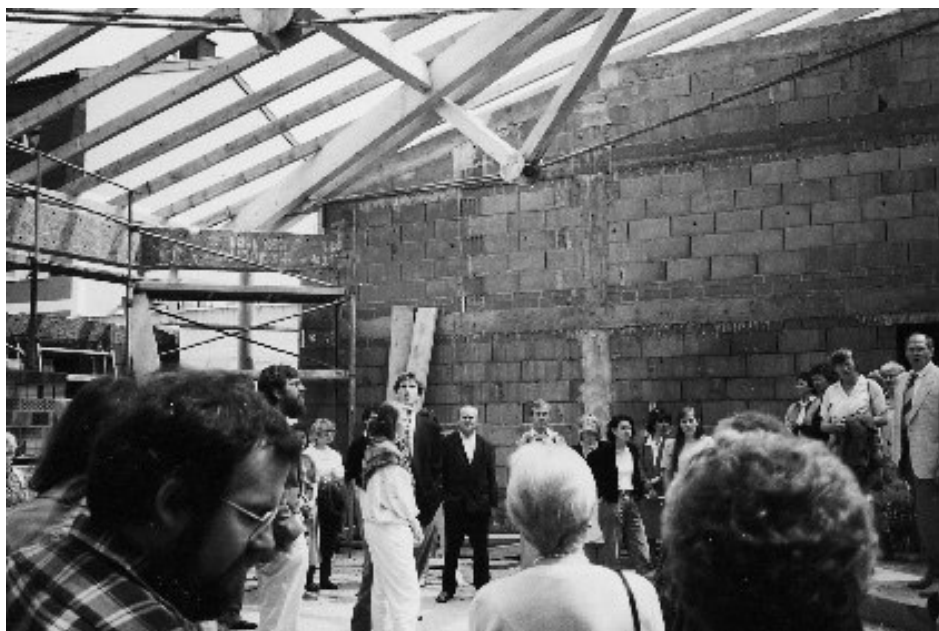
Damit wir uns beim Gottesdienst besser ansehen können, wurde beim 2. Umbau 1991 in den Hof hinein vergrößert. Das Foto zeigt das Richtfest.
